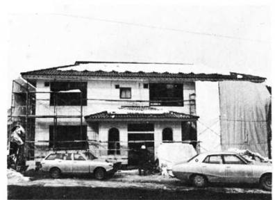
▲工事が進む集会所(尾上原集会所)
