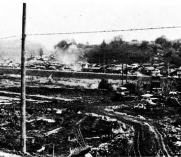
▶造成工事が進む町民総合運動場
