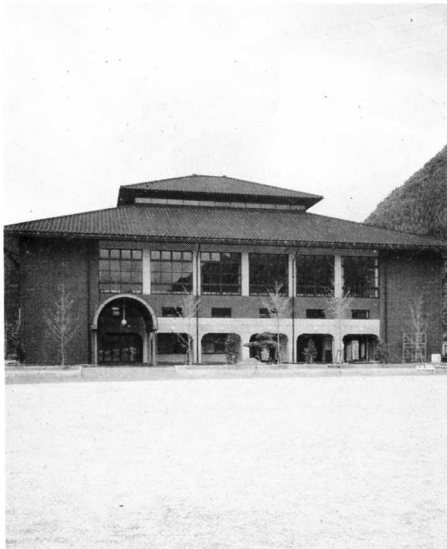
▲完成間近い町民総合体育館
