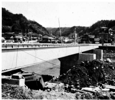
▶建設工事が進む久連橋の歩道橋
