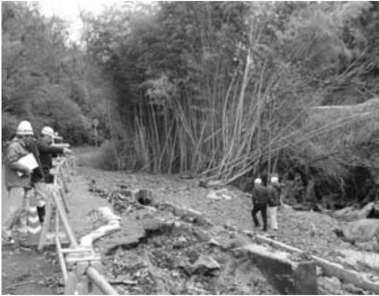
助沢地内町道大河内線災害
