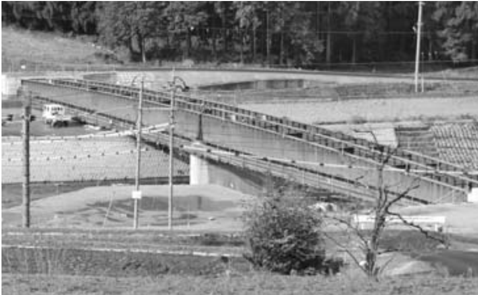
町道洲河崎下安井線道路改良工事
