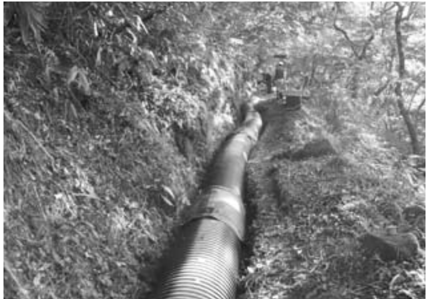
吉原河原井手水路ポリ管布設工事
