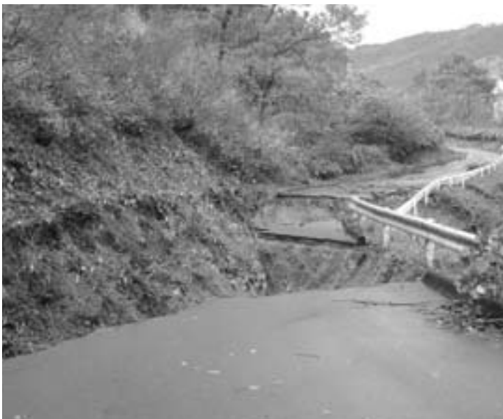
下蚊屋ダム左岸道路災害
