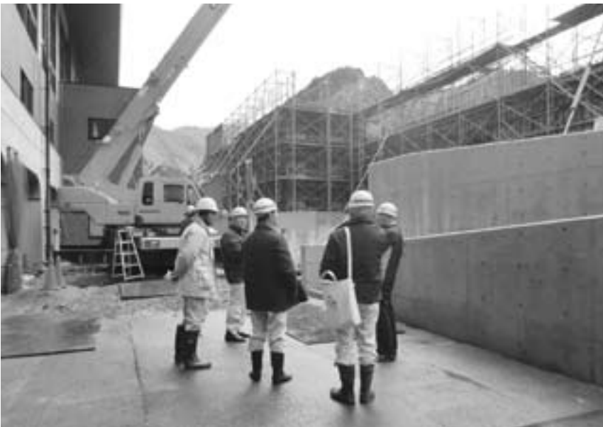
中学校建築現場
