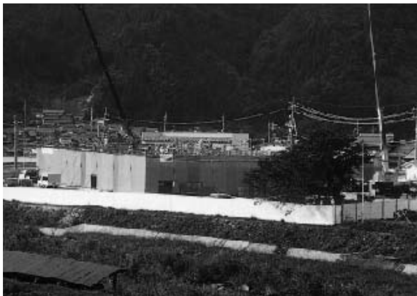
建設中の介護老人保健施設（武庫）
