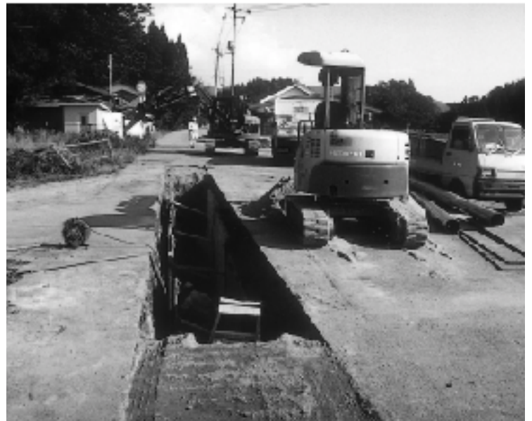
吉原地区農業集落排水工事
