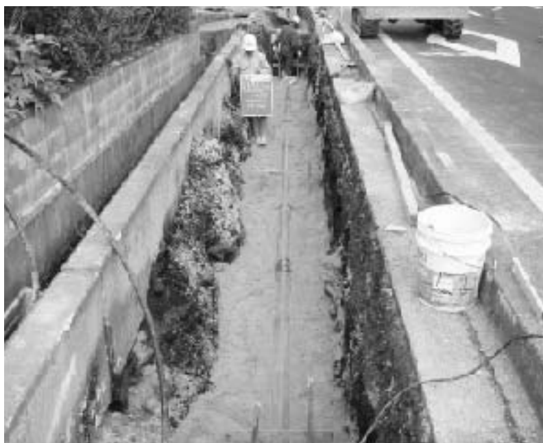
宮市地区集落排水工事
