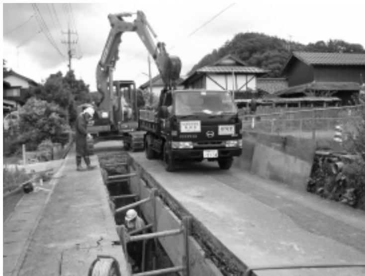
宮市地区農業集落排水工事
