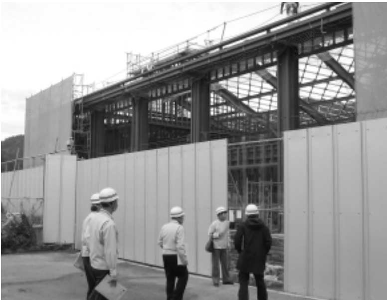
江府小学校新体育館
