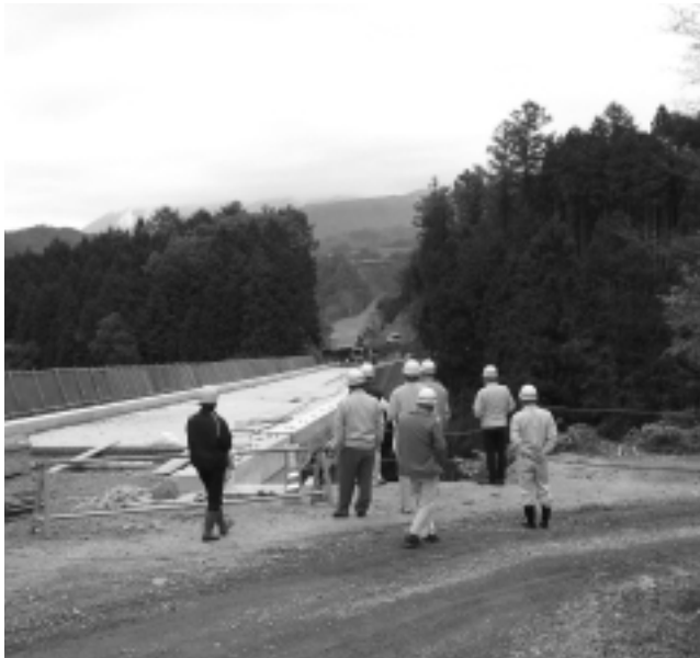
下蚊屋バイパスの進捗状況
