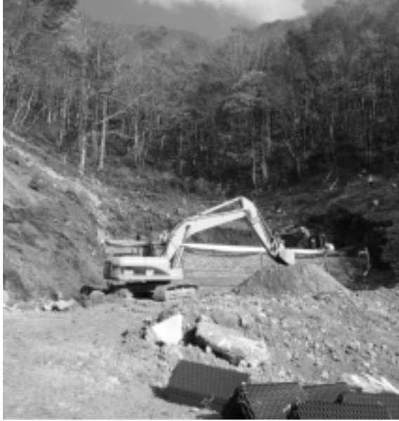
雪崩防護柵工事
