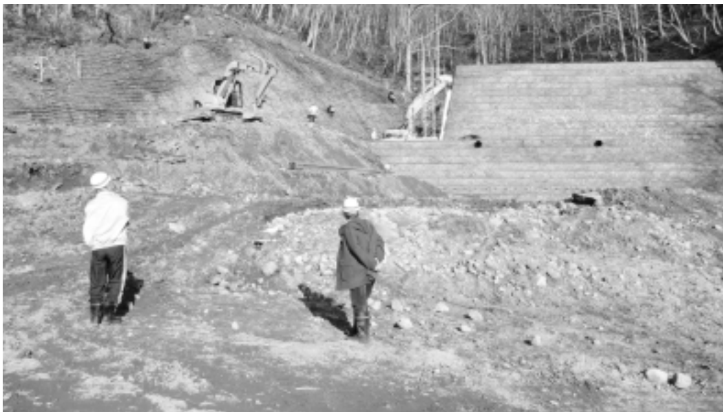
雪崩防護施設工事
