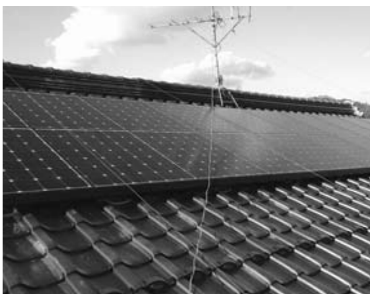
設置したソーラーパネル
