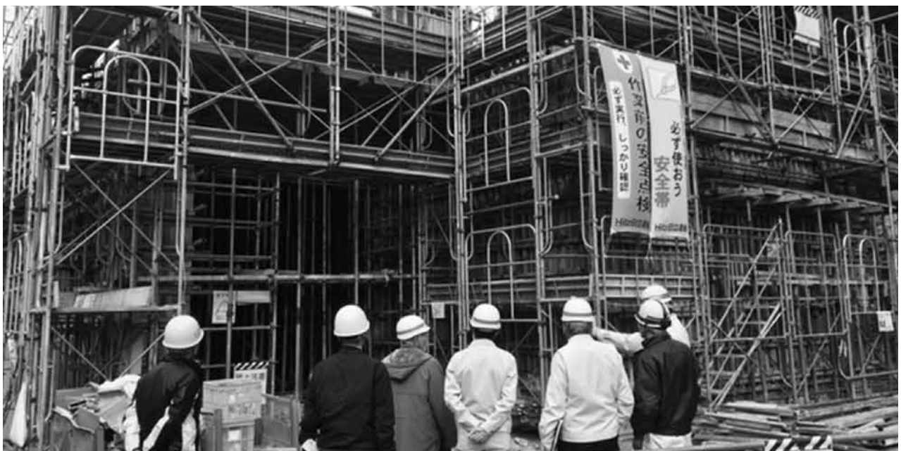
建設中の「清化園」
