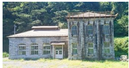
■ 旧江尾発電所(全国で現存する石造発電所11ヶ所の一つ)
