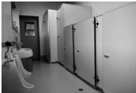
【保育園トイレ等設備改修工事】 事業費：2,253万円
