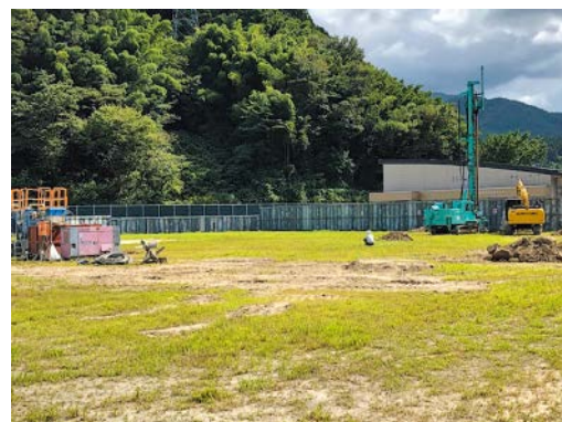
▲地盤改良工事の様子
