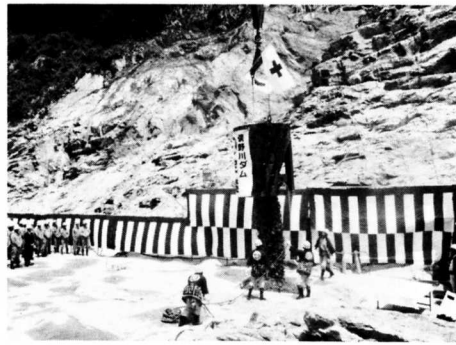
▶バケットから約二トンのコンクリートを流し込む
