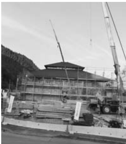
中学校建設現場
