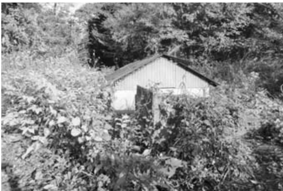
西成水道の配水地
