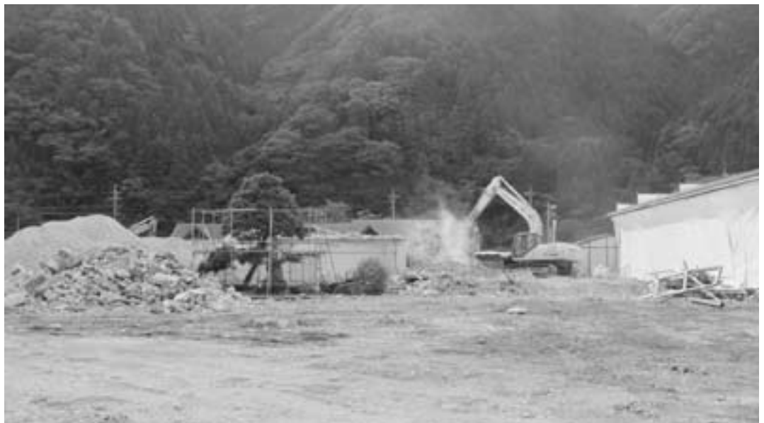
旧中学校解体工事
