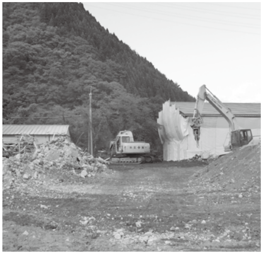
旧江府中学校解体
