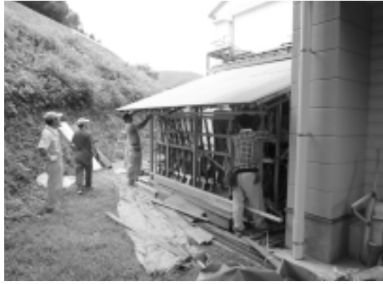
古いシートを外し、棧を取り付けます
