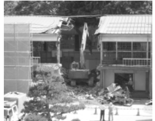
▲解体工事の様子
