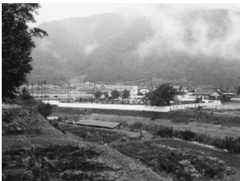
急ピッチに工事が進む介護老人保健施設「あやめ」（宮ノ前からみた工事状況）
