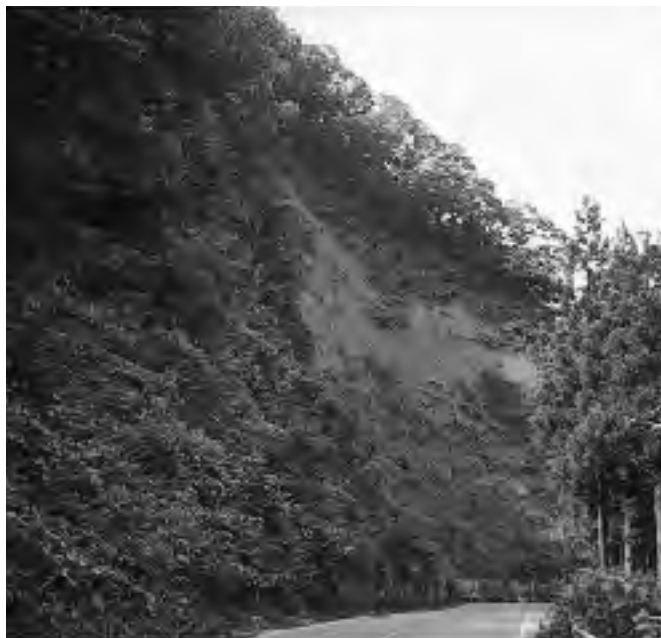
広域農道災害防除事業実施場所（下蚊屋～笠良原間）
