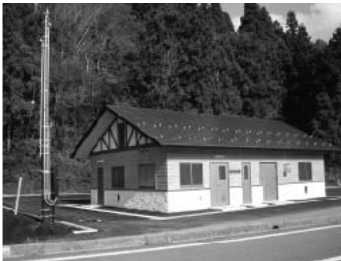
吉原地区農業集落排水処理場
