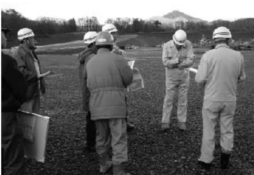
建設が進むサントリー「奥大山ブナの森工場」(笠良原)
