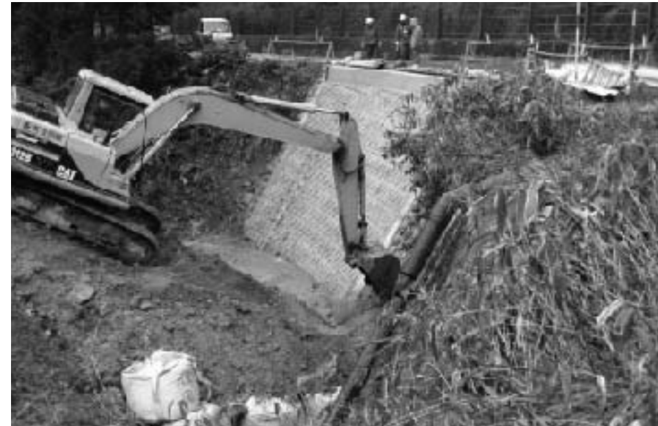
道路災害復旧工事（柿原地内）
