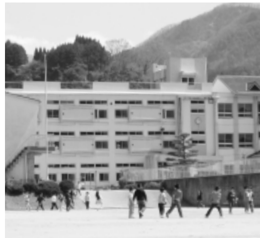
改修される江尾小学校
