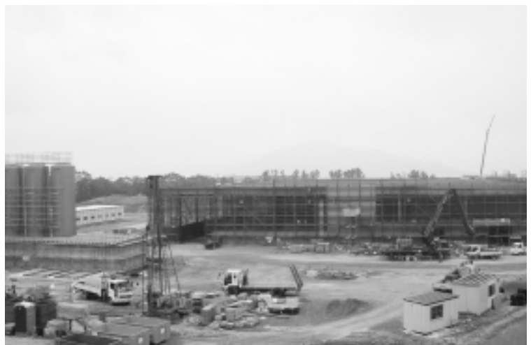
建設中のサントリー奥大山ブナの森工場
