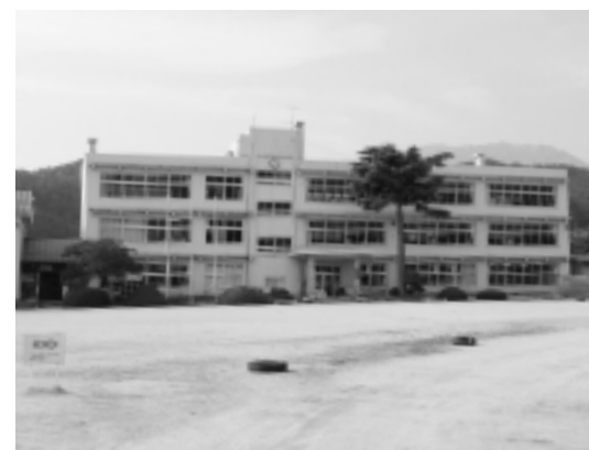
利活用が計画される米沢小学校校舎
