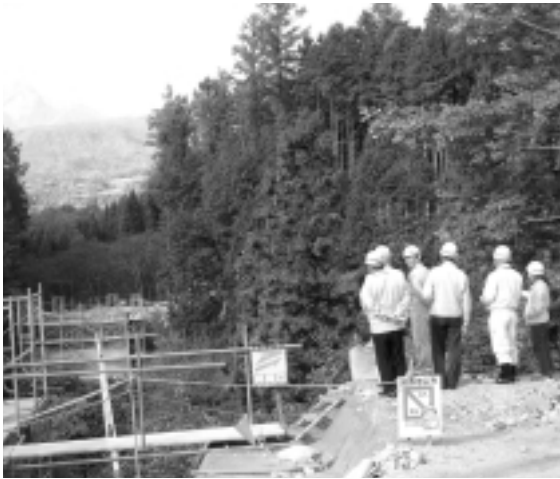
工事中の下蚊屋バイパス
