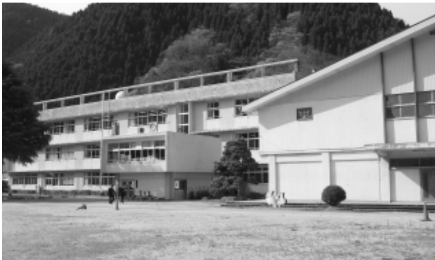
老朽化した江府中学校
