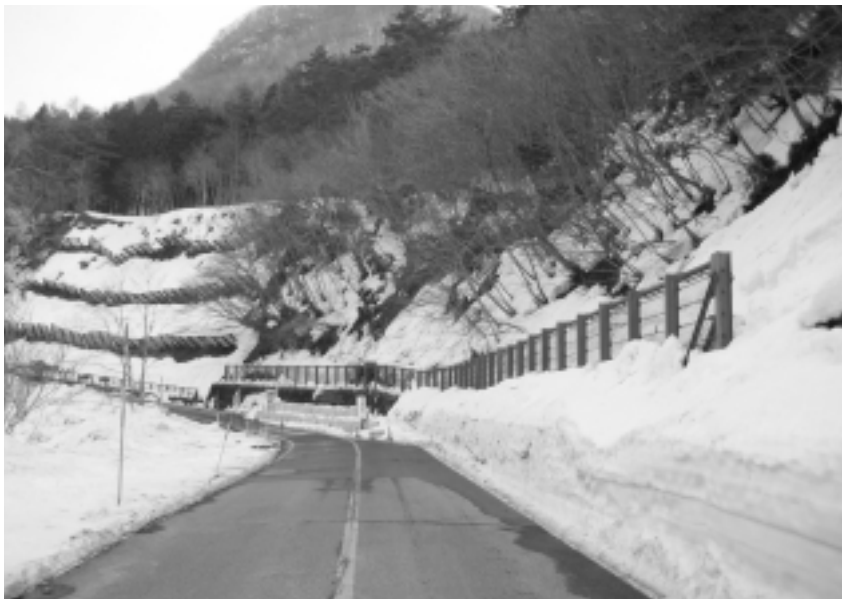
雪崩の危険のため片側通行（御机地内）
