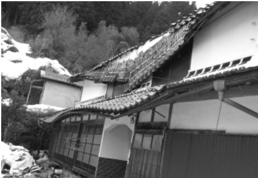
豪雪による被害(俣野地内)
