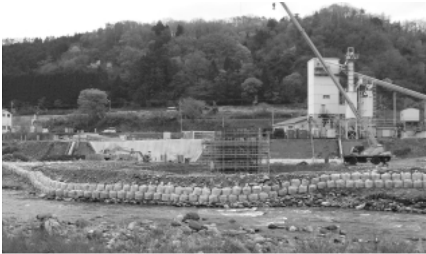
江府道路（佐川橋脚）
