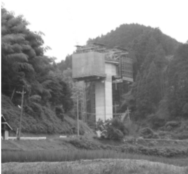
南大山農免農道 (工事中の柿原1号橋)
