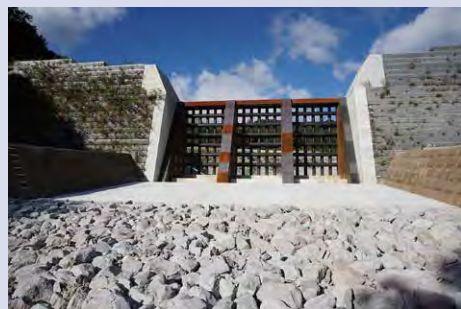
●三の沢砂防堰堤 完成
