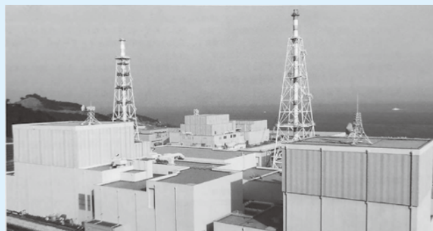
発電所一部風景向かって右から1号機3号機2号機 (中国電力(株)島根原子力本部提供資料より)
