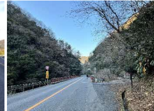
歩道が確保されていない景勝地(石蔵溪)
