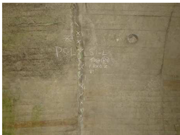
写真4.2 目地部のブロック化 左：PS、右：PE (いずれもⅡb判定)
