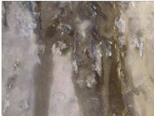
写真4.3 吹付け表面の漏水
