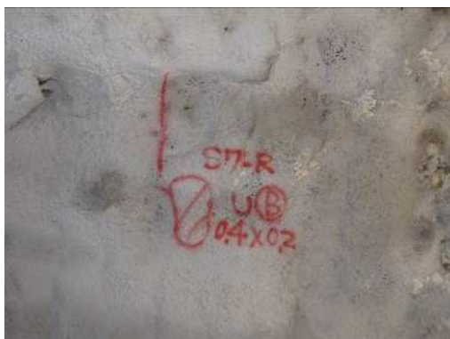
写真4.4 吹付け表面のうき、はく落箇所
