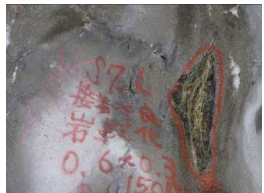
写真4.4 吹付け表面のうき、はく落箇所
