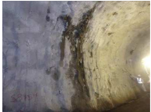
写真4.3 吹付け表面の漏水
