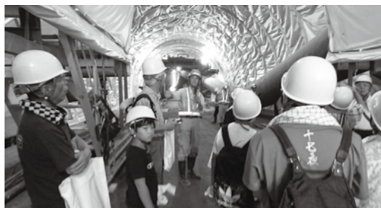
トンネル工事見学会の様子
