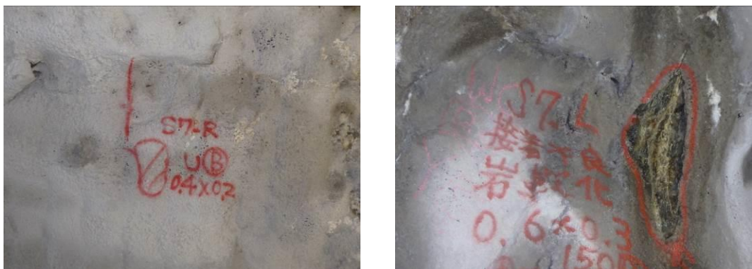
写真4.4 吹付け表面のうき、はく落箇所
