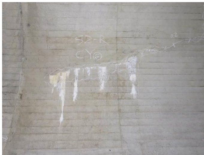
写真4.1 ひび割れ沿いの遊離石灰 S001 (I判定)
