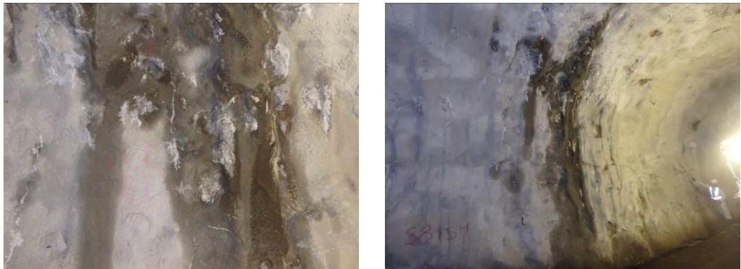
写真4.3 吹付け表面の漏水
