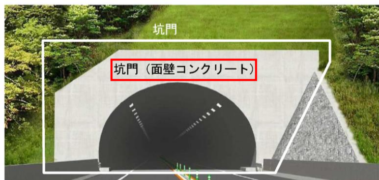
図3.1 トンネル本体工点検箇所
